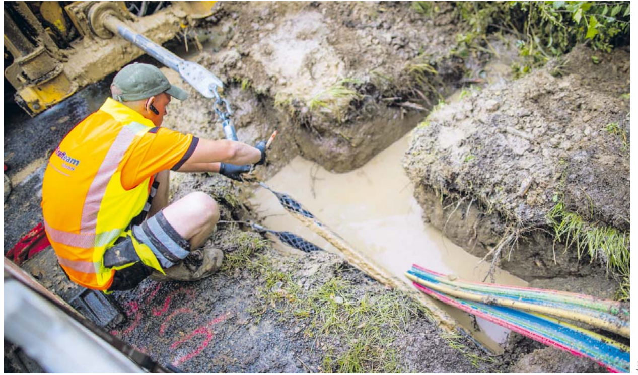
Verlegen von Glasfaserkabeln: Der Bund fördert den Breitbandausbau in unwirtschaftlichen Regionen.
