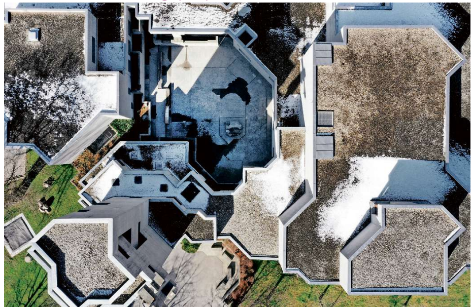
Diese Woche suchen wir im Bilderrätsel einen imposanten Gebäudekomplex in Chur. Die Auflösung gibt es wie immer in der Ausgabe von morgen.
